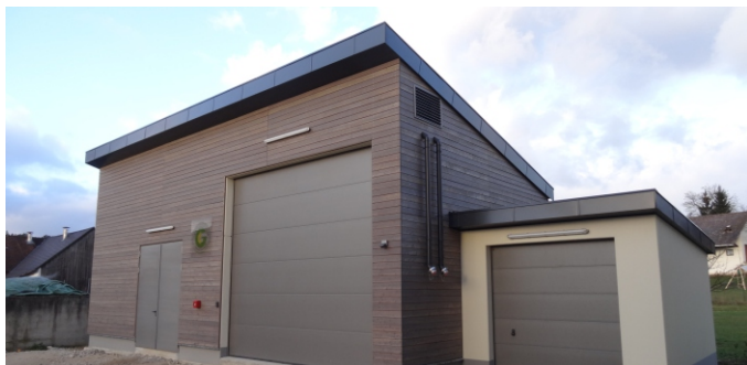
Das Heizwerk im Ortskern Oberleiterbachs
